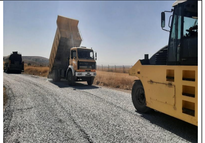
GÖKDERE- BELEKÇİHAN 2. KAT ASFALT ÇALIŞMASI
