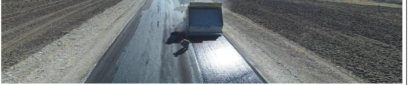
BENLİ KÖYÜ 1. KAT ASFALT ÇALIŞMASI
