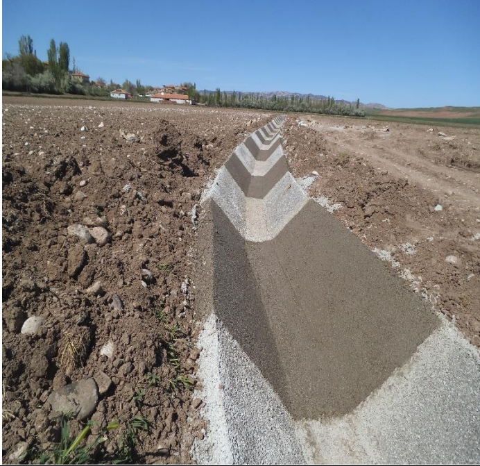
AĞAÇLI, PINARBAŞI SULAMA ÇALIŞMASI
