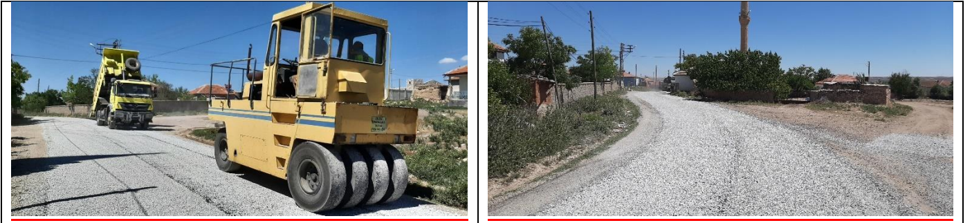
EKİZCE- ÇELTEK 2. KAT ASFALT ÇALIŞMASI
