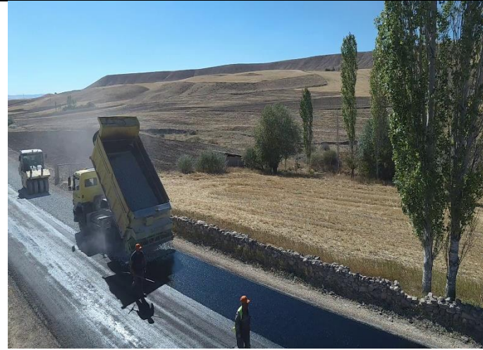
ŞAHANDERESİ-KUŞKAYASI 1. KAT ASFALT ÇALIŞMASI
