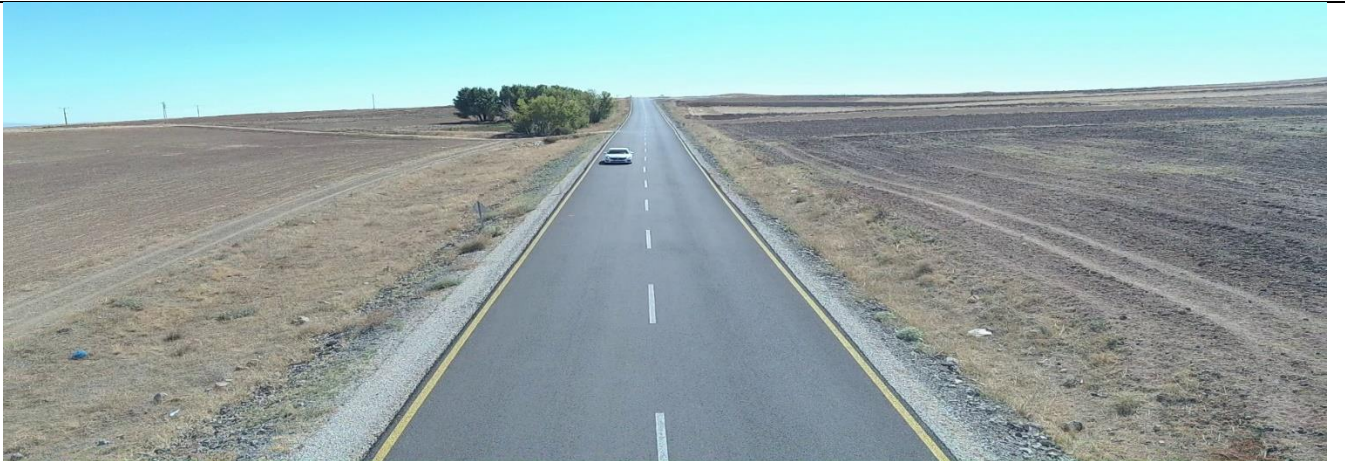
ŞAHMURATLI BSK YOL ÇALIŞMASI
